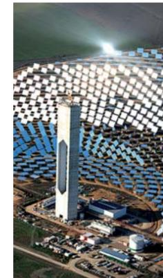
TORRE RECEPTORA DEL HAZ SOLAR EN UNA PLANTA DE GENERACIÓN TERMOSOLAR.
